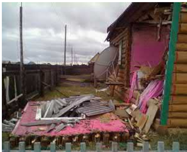
Рис. 2. Фотография дома, разрушенного взрывом шаровой молнии
