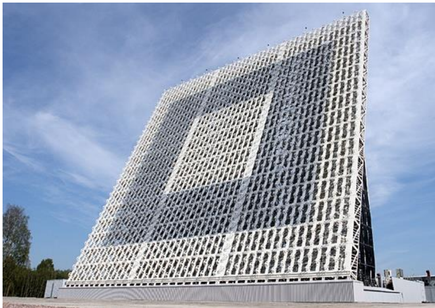
Рис. 1.10. Радиолокационная станция надгоризонтного обнаружения целей «Воронеж-М» с дальностью до 4 – 6 тысяч километров
