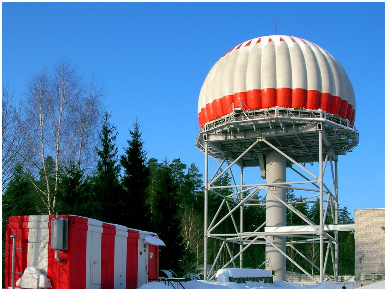
Трассовый радиолокационный комплекс (ТРЛК) "Утес-Т" на РЛП "Дзержинск"
