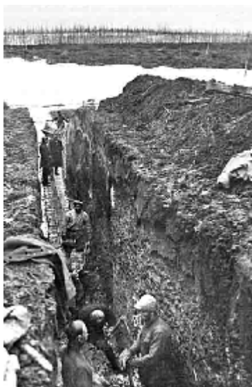
Рис. 26. Отводная канава (по Бронштэну, 49)
